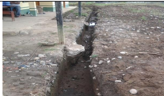
Canales para drenaje de agua
